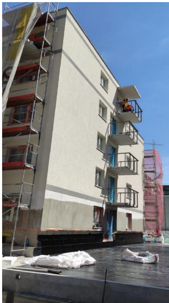
Źródło: Zdjęcie z 04.08.2022 r. – fragment elewacji południowej budynku: gotowa wyprawa elewacyjna (od poziomu I piętra), trwa montaż balustrad balkonowych.
