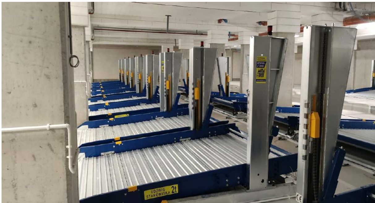
Źródło: Zdjęcie z 04.08.2022 r. – zamontowane platformy parkingowe w garażu na poziomie -1.
